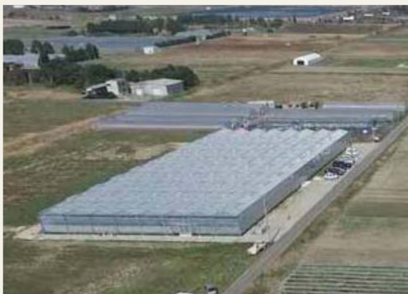
▼養液トマト栽培用大型ハウス
